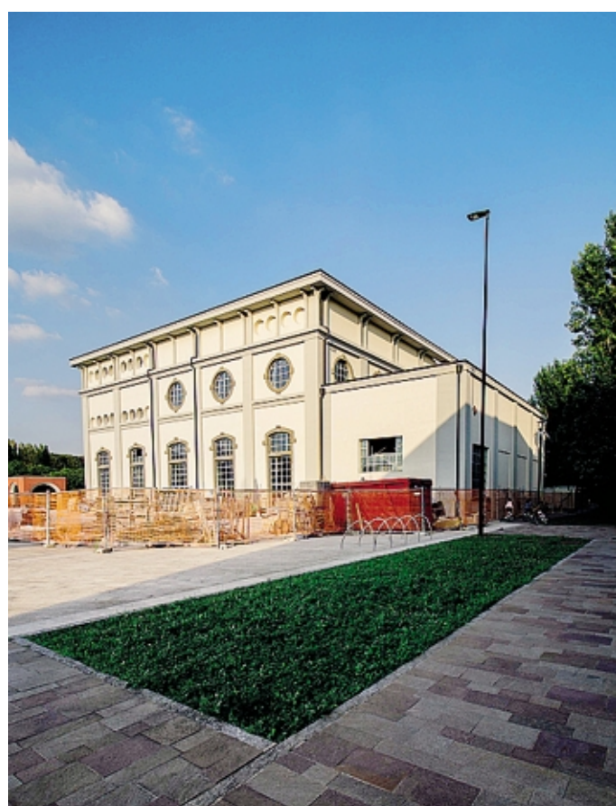
L'ex centrale Daste e Spalenga
